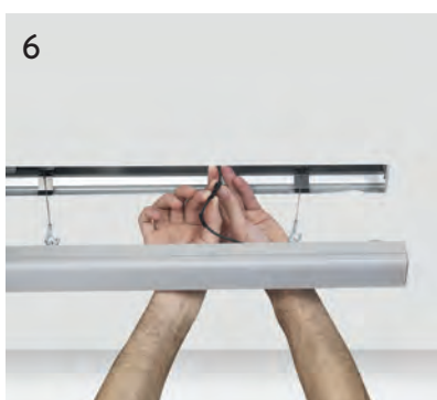
5 - Inserimento del modulo strutturale a scatto e collegamento alla rete. Insertion of the snap-in rail module and connection to the mains.
